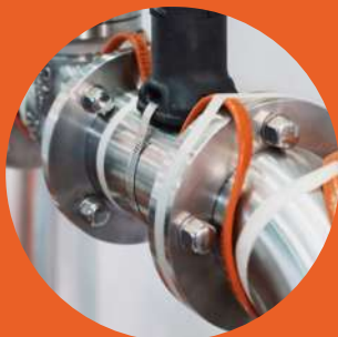
Heat Trace (Aislación y Cinta)
